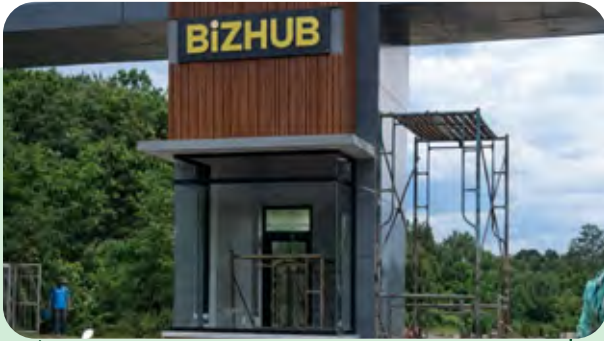
Pembanguna Pintu Gerbang dan Pagar di Bekasi, Jawa Barat
