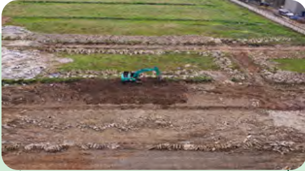
Cut and Fill Perkerasan Jalan di Bekasi, Jawa Barat
