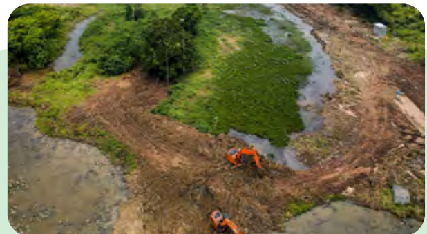
Pekerjaan Cut and Fill Tanah dan Penahan Tanah di Jakarta Timur
